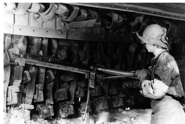
Уральский алюминиевый завод. Работа у электролизной ванны
