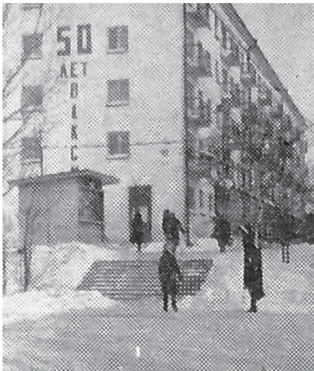
ул. Дзержинского, д. 12
